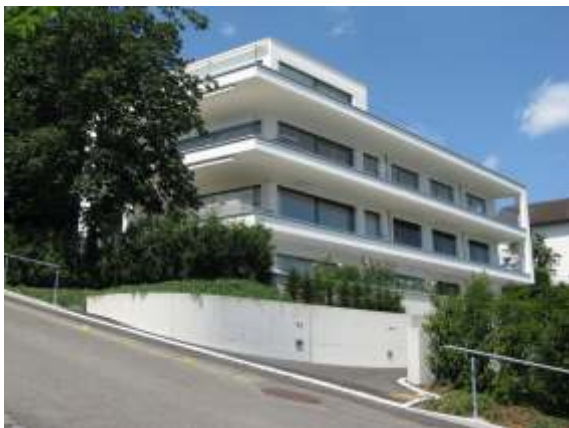
EFH Thalwil Lamellenstoren Kassettenmarkisen
