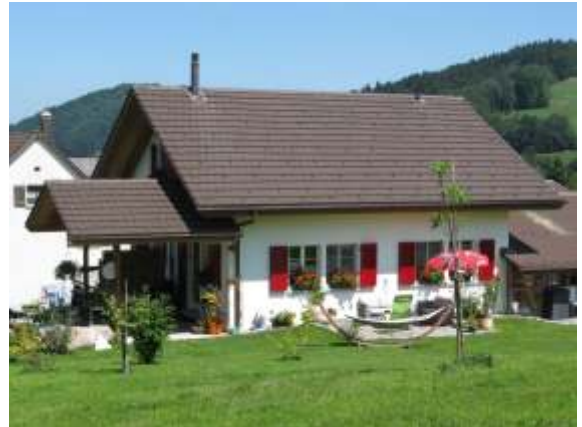
▶ EFH Bäretswil Alufensterläden
