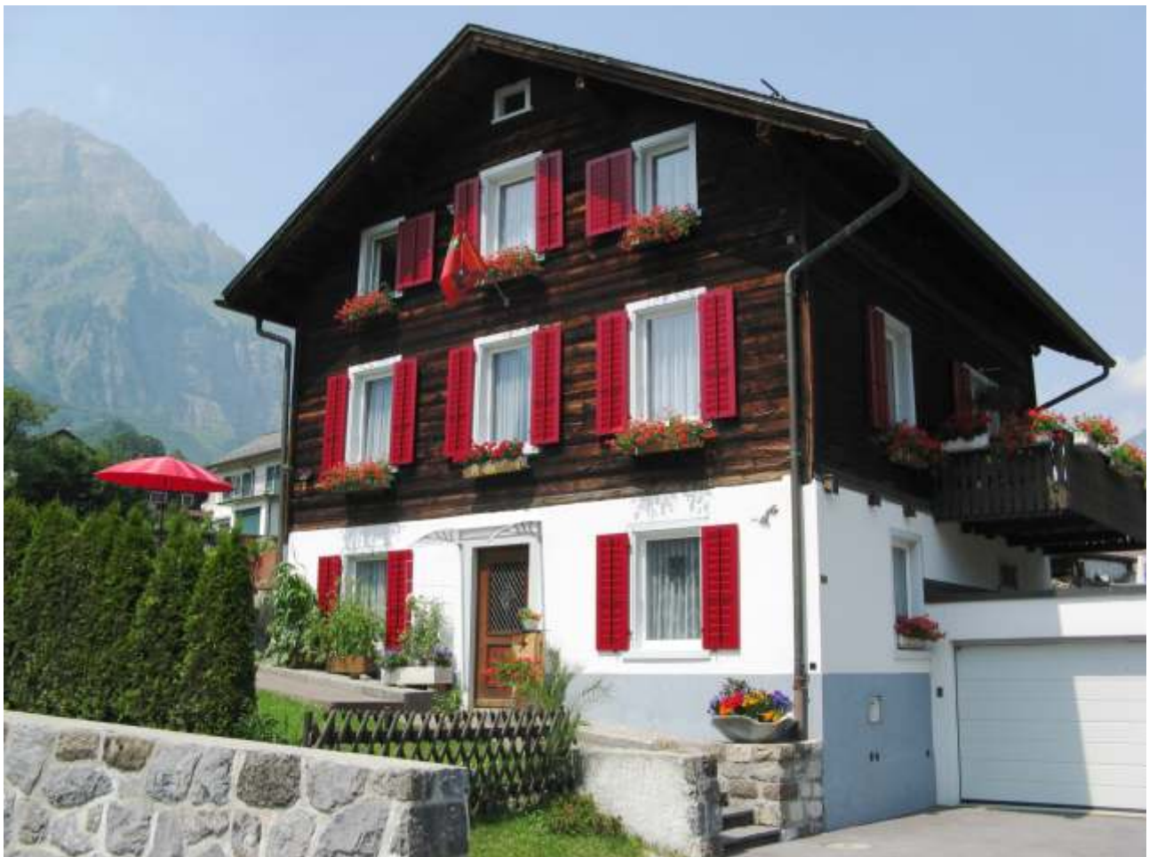
▼ EFH Schwanden Alufensterläden
