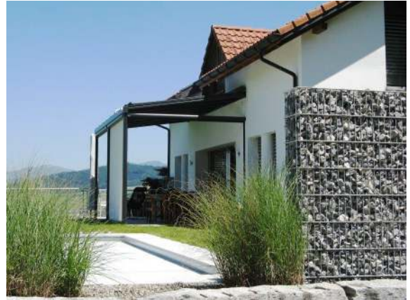
EFH Umbau Terrasse Siebnen Pergola ▶
