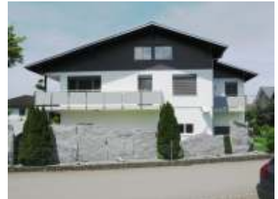
► EFH Wangen Aublenden Lamellenstoren
